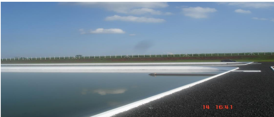
Lagoa de tratamento
