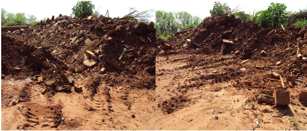
Figura do local de disposição de (RCC)- (Aterro desativado)
