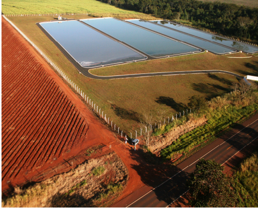
Vista Aérea Lagoa de Tratamento
